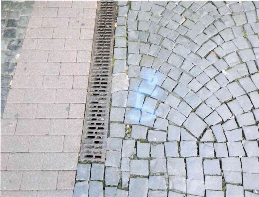
Bild 2: Exemplarische Darstellung der Entwässerungsrinne im Basaltpflaster, Aufschluss EK 5
